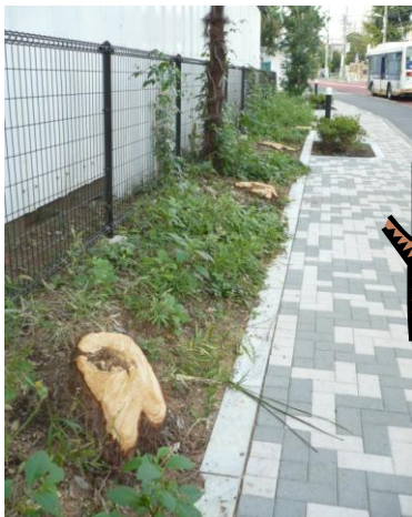
歩道拡幅により根切りしたために伐採した木々
