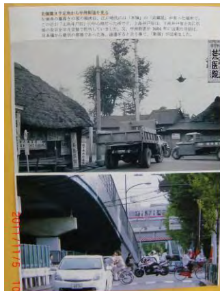
甲州街道と環状8号線交差付近 （上北沢4丁目）
