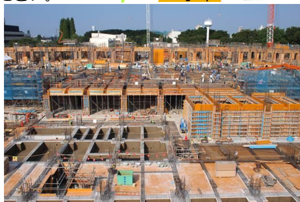
↑松沢病院新館工事↑
