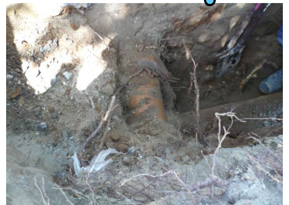
試験堀：桜の根が水道管に巻きついている状況
