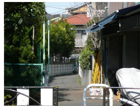
甲州街道北側の暗渠部分 (上北沢5丁目8番と9番の間)
