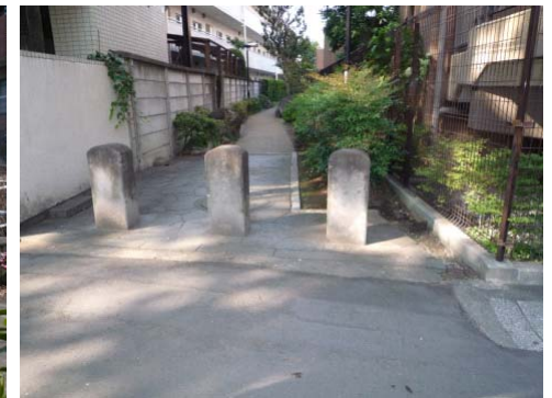
暗渠の上は遊歩道
