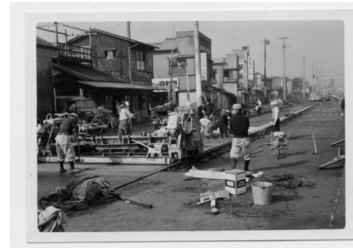
昭和30年代中頃の甲州街道 (拡幅工事中、現 上北沢駅入口付近)
